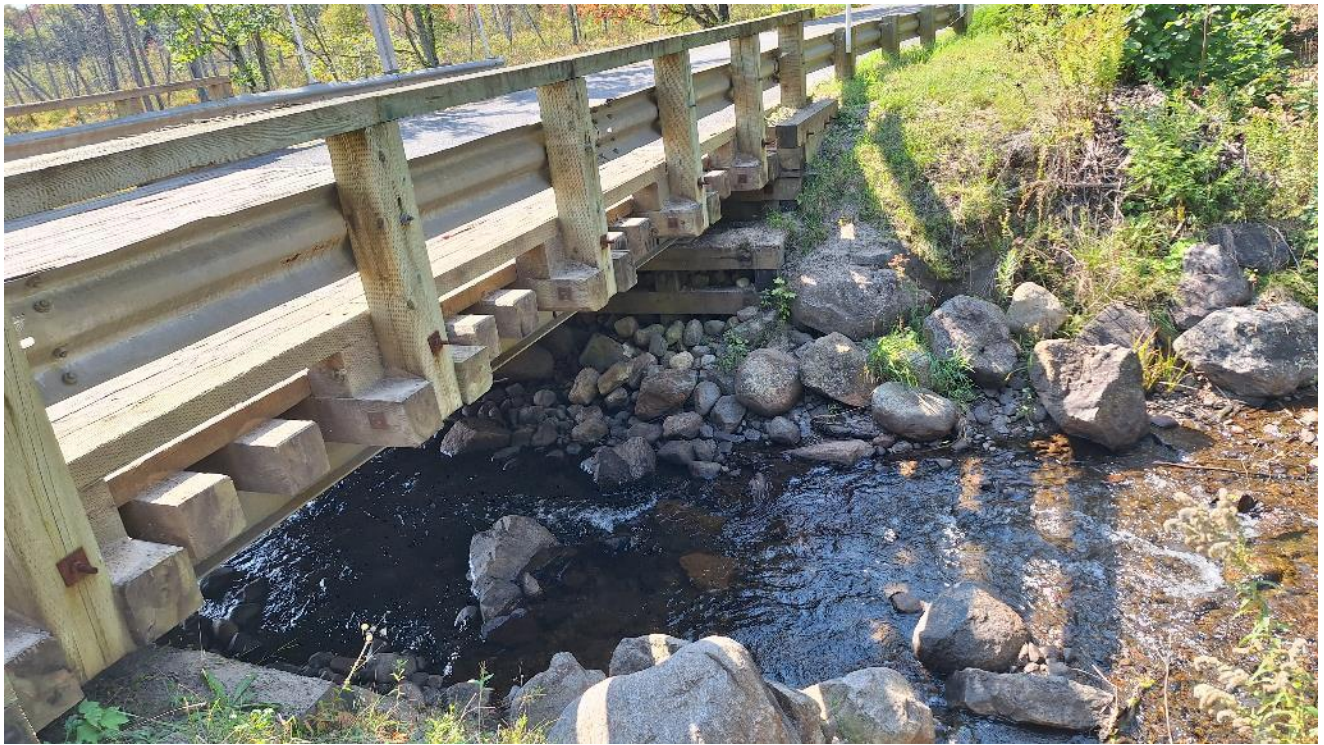
PHOTOGRAPHIE 9 : PONT SUR LE CHEMIN LAC LOUISA SUD
